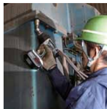
設備のメンテナンス作業に
