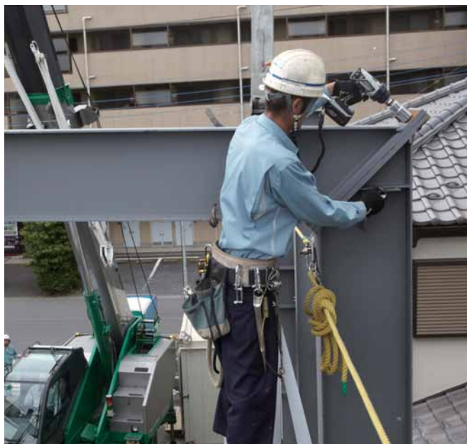
建て方工事の仮締め
