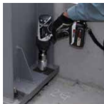
アンカーボルト締め付け工事に
