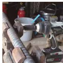
圧接作業の鉄筋固定に
