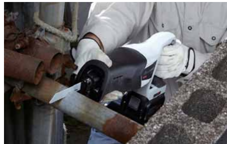
単管パイプ切断に
