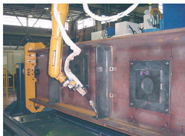
梁フランジ×スチフナー溶接
